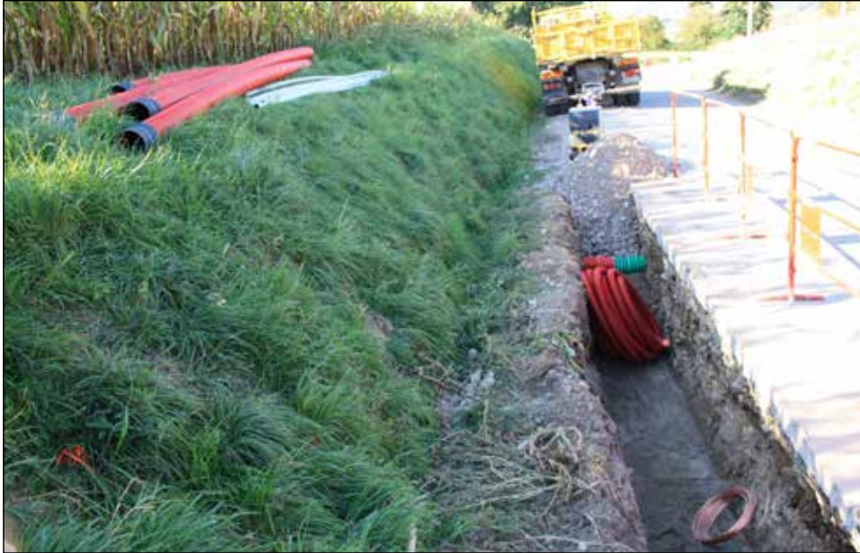
Première tranchée route de Tignerand.
