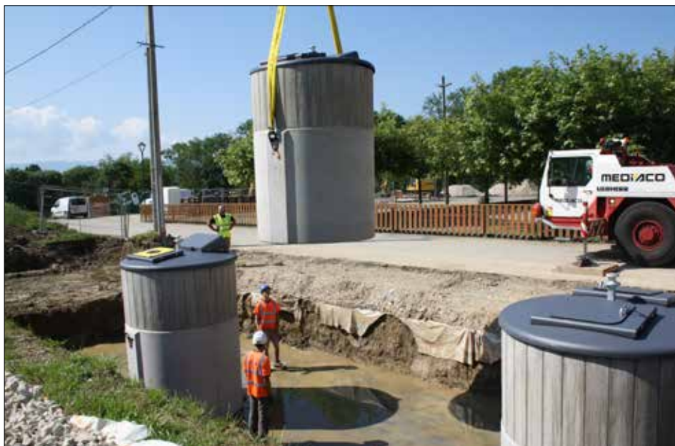
Une grue et la fermeture de la route ont été nécessaires lors de l'implantation.
