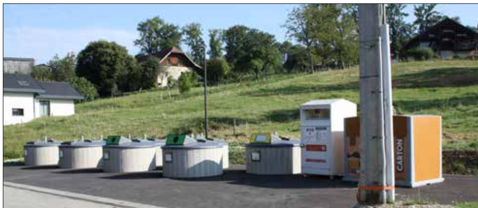
Des arbustes seront plantés prochainement autour de cet équipement.
